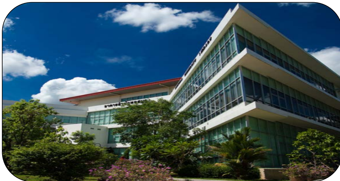
อาคารแสงเทียน(อาคาร 4 ชั้น)
