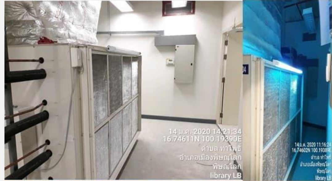
การติดตั้งหลอดรังสี UV-C ภายในห้องเครื่องปรับอากาศแบบรวมศูนย์ (AHU)
